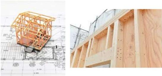
近年、地球温暖化防止策の観点から温暖地でも高い省エネルギー性能のニーズが高まっています。ツーバイフォー住宅は断熱性や気密性に優れ、冷暖房効率が高いのが特徴です。暖冷房エネルギーのロス減らすには、建物の隙間をふさぐことで気密性を高めることが重要です。モノコック構造のツーバイフォー工法は、この点からも優れています。
